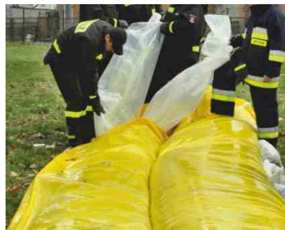
Zapora przeciwpowodziowa 10 m z rękawem wew. 23 m (folia LDPE) Flood barrier 10 m with internal sleeve 23 m (LDPE)
